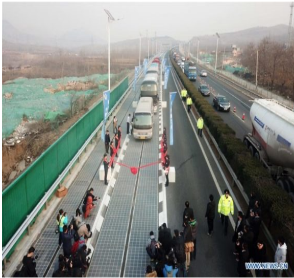
Autobahn PV Straßenbelag China
