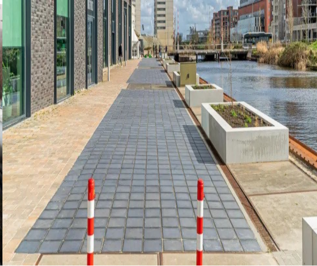
Fußgänger PV Groningen
